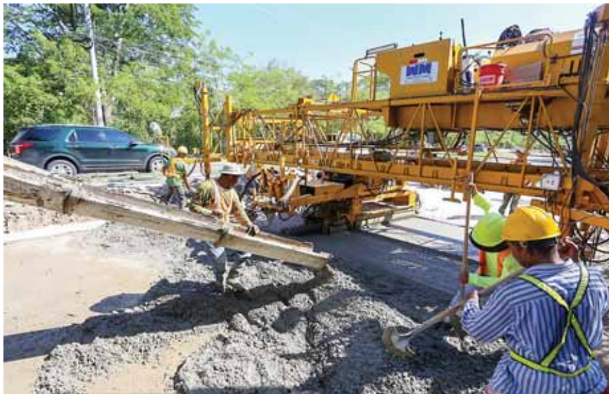
A la fecha, el proyecto presenta un avance del 30% y se ha pavimentado un kilómetro de los 2.5 que comprende la obra.
