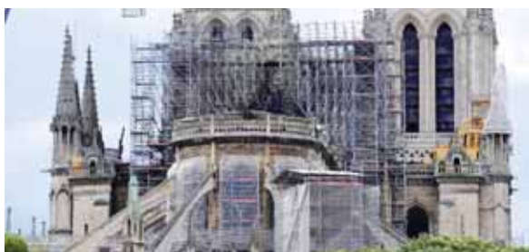
Las obras en curso en la catedral están destinadas a consolidar el edificio gótico.
