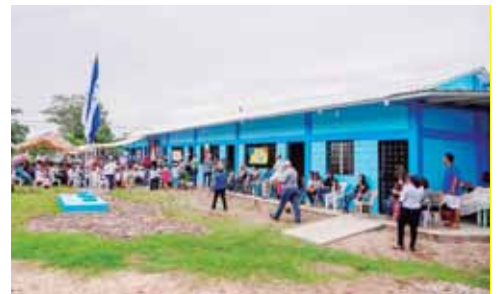
Cada escuela FEIH cuenta con 6 aulas y 6 baños sanitarios, sistema eléctrico, pupitres, pizarras, escritorios, áreas recreativas, tanque de agua potable, fosa séptica y biblioteca.
