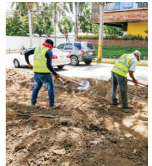
Actualmente se está trabajando en el trazado y marcado de lo que será un sendero.
