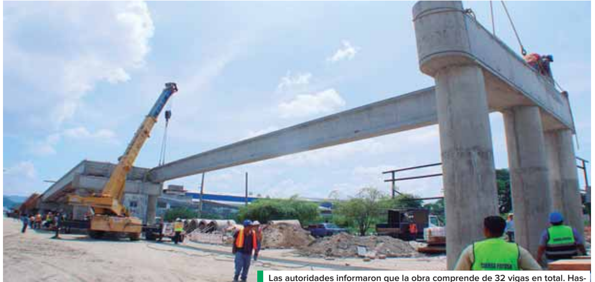
Las autoridades informaron que la obra comprende de 32 vigas en total. Hasta el momento se han colocado 20 vigas lo que representa el 28% de avance.
