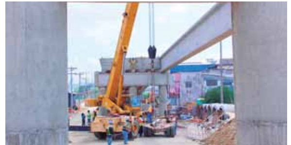
La obra beneficiará a miles de conductores que transitan por la avenida, al igual de mejorar el flujo vehicular.
