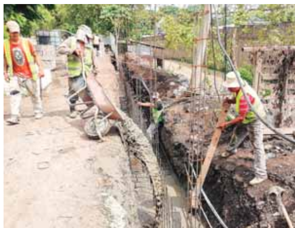
El proyecto consiste en la reconstrucción de 43 metros lineales del muro perimetral del cementerio sampedrano.
