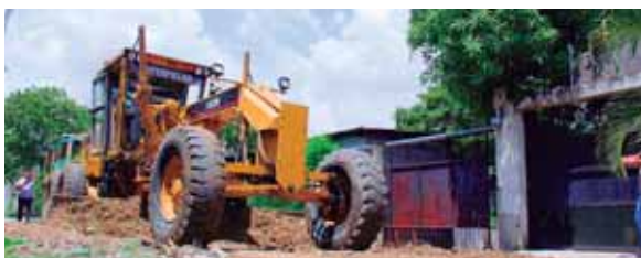
El proceso de reparación comprende inicialmente la limpieza de las zonas contaminadas, luego se procede a realizar el relleno.
