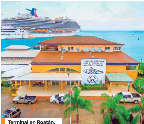
Terminal en Roatán.
