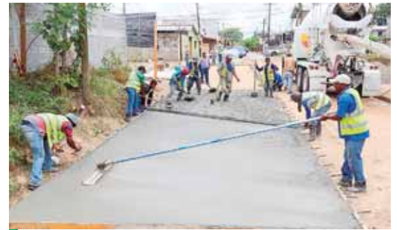
Una vez finalizada la obra continuarán las labores en el componente pluvial del proyecto que serán los quiebrapatas.
