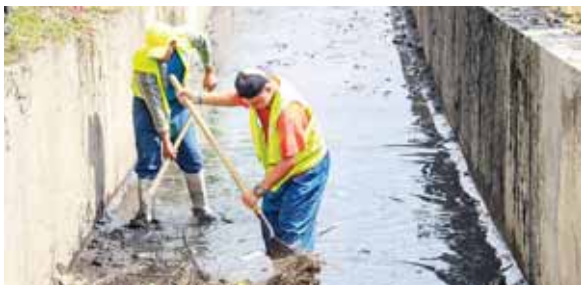
El trabajo de mantenimiento pluvial permitirá que no haya inundaciones en la zona.
