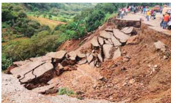
Los habitantes del occidente quedaron sorprendidos por la falla geológica que ocurrió la noche del pasado lunes.
