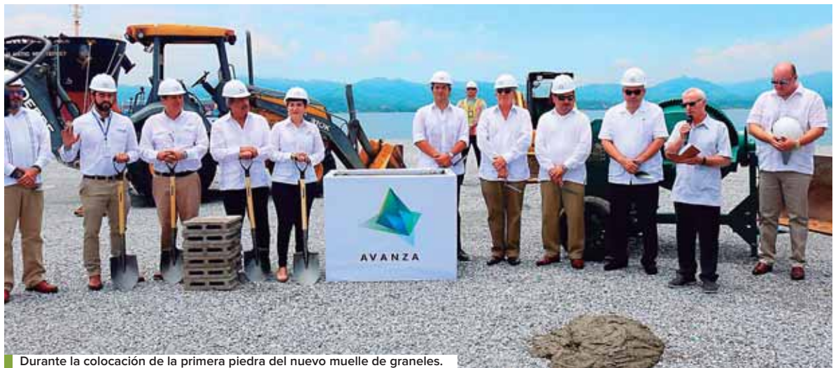
Durante la colocación de la primera piedra del nuevo muelle de graneles.
