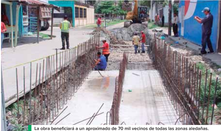
La obra beneficiará a un aproximado de 70 mil vecinos de todas las zonas aledañas.
