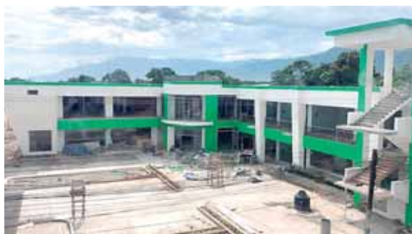
Otro de los inmuebles asegurados fue un centro comercial en plena construcción vinculado a socios de “Los Cachiros”.
