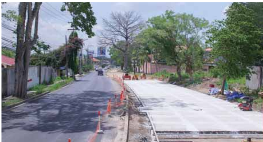
La pavimentación de la trocha oeste del bulevar Mackay, incluirá la pavimentación de más de 2.5 kilómetros de losas de concreto hidráulico.
