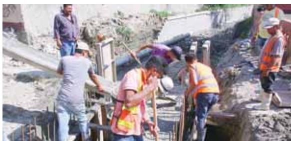
El colector de aguas lluvias del sector Lomas del Carmen comprende la construcción de una obra de descarga en el río Sauce.
