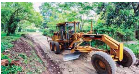
La red vial no pavimentada continúa con los trabajos que permiten mejor movilidad a los conductores y peatones de varias colonias.
