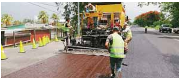
Al finalizar este tramo, los equipos municipales continuarán trabajando en la prolongación de la Avenida Júnior.
