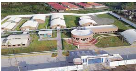
Durante la ejecución de la obra hubo 746 empleos entre directos e indirectos, pero para funcionar se contratará a 100 personas.
