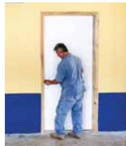
Parte de las mejoras fue restaurar módulos y revisión del sistema eléctrico.
