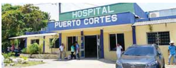
También se le dará mantenimiento a la subestación eléctrica, a la planta de emergencia, a los paneles de aislamiento, entre otros.
