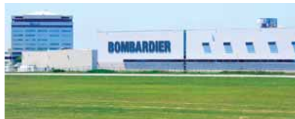
Un hangar Bombardier en la pista del Aeropuerto Internacional de Montreal Pierre Elliott Trudeau en Montreal.
