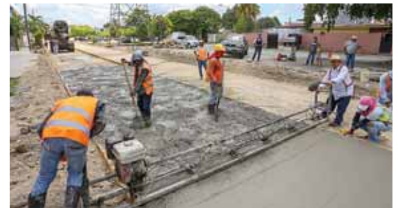
La obra se extiende a lo largo de 500 metros lineales y comprende la construcción de aceras, bordillos y rampas.
