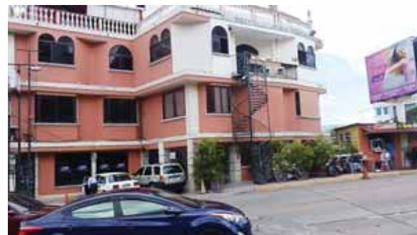
Este edificio tiene varios departamentos. Entre las irregularidades encontraron medidores desconectados.
