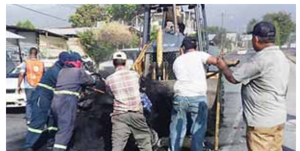
Los equipos municipales, desde horas muy tempranas liberaron las vías de escombros para el paso vehicular.
