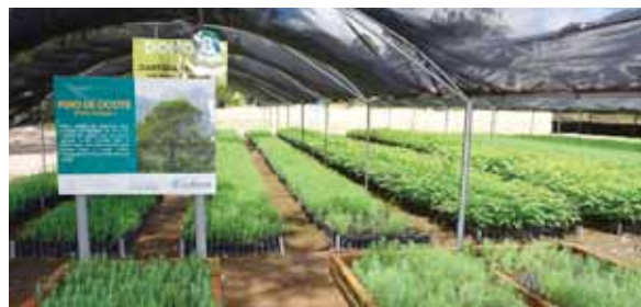
Vivero construido por Lufussa en el plantel del ICF en Guaimaca, Francisco Morazán.
