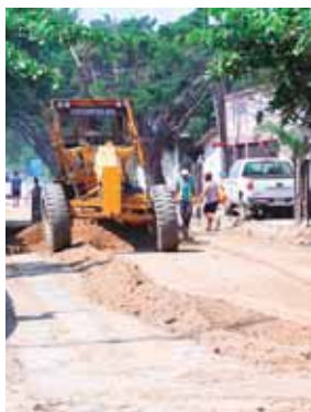
La calle donde se realiza el proyecto sirve de acceso a otras vías.
