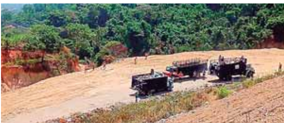
La calle de acceso fue reparada. Así los camiones entran con facilidad.
