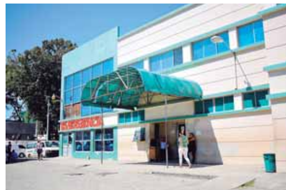
En el proceso de recuperación a consecuencia del desfalco, se hicieron obras de remodelación.
