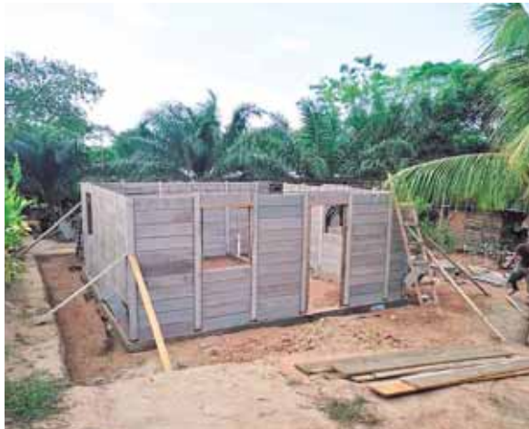
Una de las casas que ya está siendo construida en Tronconeras.
