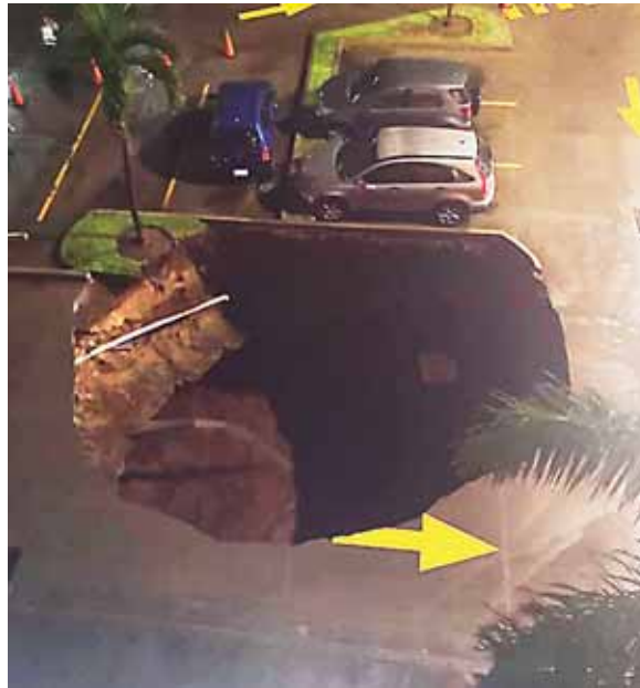
Un inmenso cráter se formó en un establecimiento comercial ubicado en Tegucigalpa poniendo en peligro la vida de las personas.
