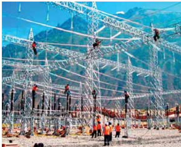
Los generadores de energía señalan que hay licencias que no han sido ejecutadas por muchos años.
