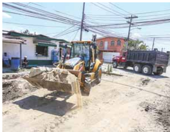
Ayer los equipos municipales realizaron trabajos de excavación y relleno con material selecto.
