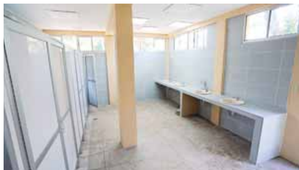
Se ejecutaron trabajos de fundición de pisos, instalación de tubería de agua potable, sistema de aguas negras y levantaron las paredes.
