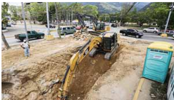
Por la construcción que se lleva a cabo en la trocha que va de sur a norte los que transitan por este lugar deberán tomar vías alternas.
