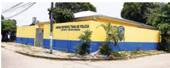
El edificio funcionará para atención de los vecinos, pero también cuenta con dormitorios para los policías asignados a la zona.
