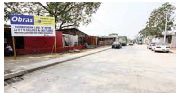
El paso vehicular ya fue habilitado. Los pobladores dijeron estar agradecidos con la municipalidad por la obra.
