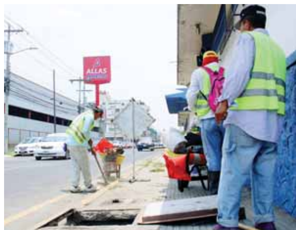
Los trabajos permiten que los conductos de aguas lluvias estén limpios. Son varias las cuadrillas diseminadas.
