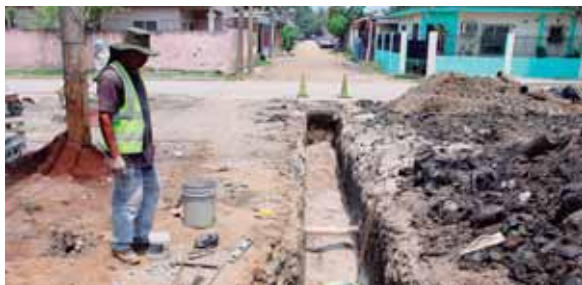
El proyecto se convertirá en un alivio para los vecinos de la zona ya que tendrán mejor acceso. También tendrán mejor sistema de aguas negras.
