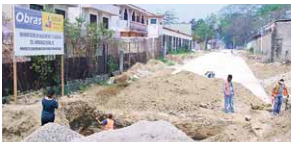
Las losas de concreto hidráulico se han terminado. Ahora se trabaja en la construcción de las obras de captación de aguas lluvias.
