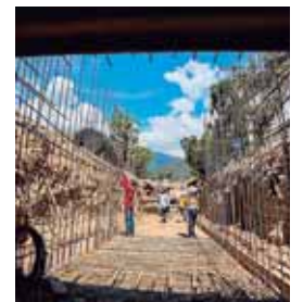
La obra mitigará inundaciones en el sector noroeste.
