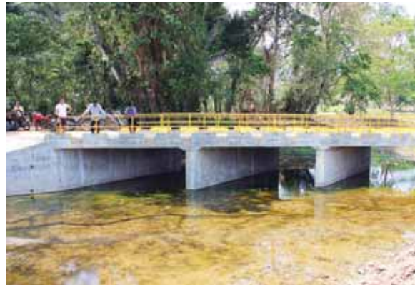
La caja puente permitirá canalizar mejor las aguas y disminuirá la posibilidad que se inunden caminos y campos productivos.
