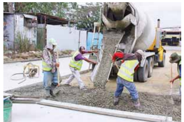
Preliminarmente se ejecutaron trabajos de levantamiento topográfico y limpieza del área.
