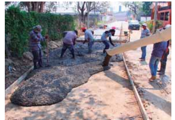
En estos momentos realizan trabajos de fundición en la colonia Hernández Morel.
