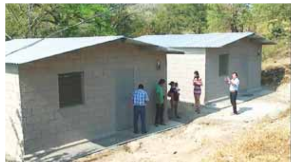
Momento en que entregaban la casa en la colonia Walter Perdomo. La otra vivienda se ubica en la colonia Linda Coello.
