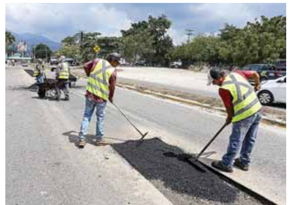
Los equipos municipales están reparando baches con concreto hidráulico y asfalto, también reemplazan adoquines en mal estado.
