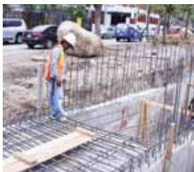
Este proyecto mitigará los problemas de inundación en el bulevar al Mario Rivas.
