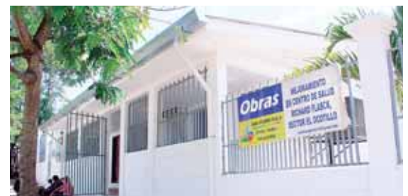
Las mejoras incluyeron la instalación de un nuevo sistema eléctrico y de iluminación. También se cambió el cielo falso y piso.
