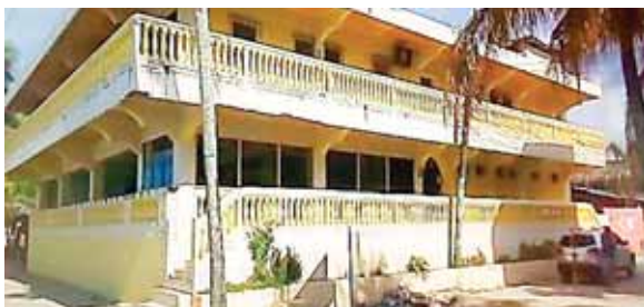
Entre este hotel y la gasolinera la empresa energética estima una pérdida de más de 50 mil kilovatios.
