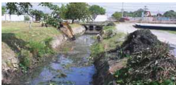
Con maquinaria pesada pero también mediante trabajo manual se están ejecutando los trabajos.
