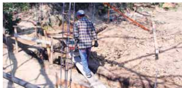
Se contempla la construcción de un módulo de tres aulas, para que los beneficiados reciban atención integral en instalaciones adecuadas.
