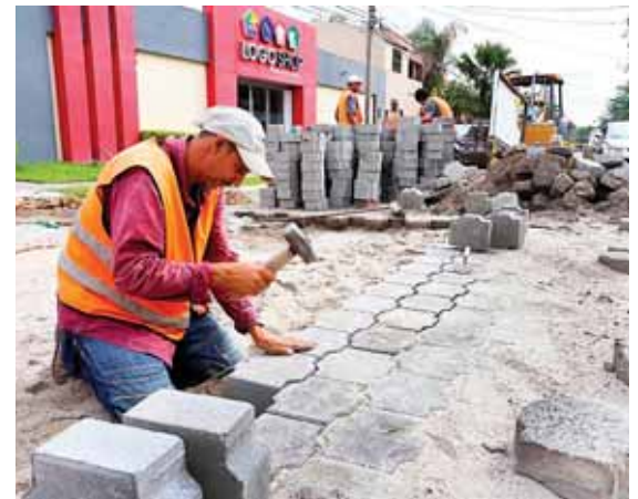
Los equipos municipales mientras trabajaban en la reparación de algunas calles de la colonia Universidad.
