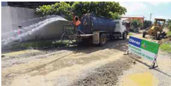
Los equipos municipales continúan trabajando en colonias como Luisiana, Buena Vista, Santa Martha y Vida Nueva.
