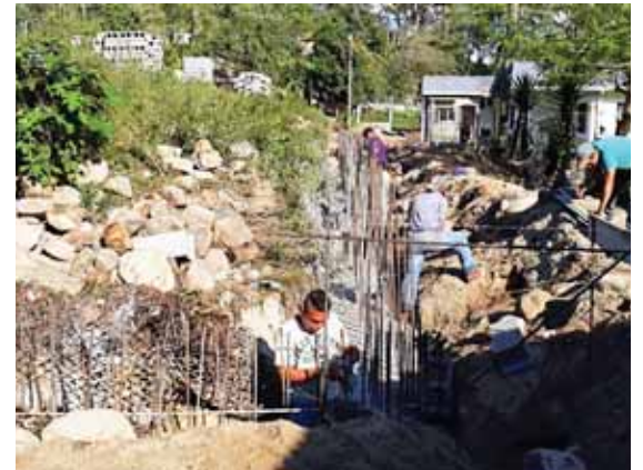
La obra también incluye la construcción de un muro perimetral de 52 metros lineales.
