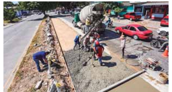
Esta obra consiste en la ampliación de un carril adicional para los giros a la izquierda desde la circunvalación.
