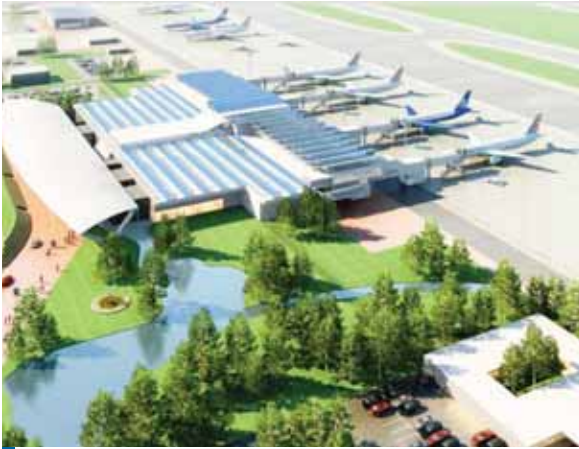
En noviembre del año en curso se espera que concluyan los trabajos para que comience sus operaciones en 2020.
