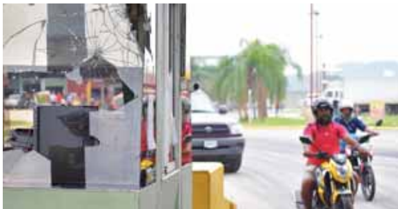
Las ventanas de las casetas que dan acceso al predio de la central fueron rotas a pedradas.
